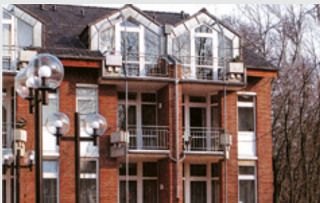
Ausbau des alten Voerder Rathauses zum AWO-Seniorenheim.
