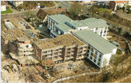
Baubeginn Wilhelm-Lantermann-Karree, Dinslaken. Rückbau der Altgebäude.
