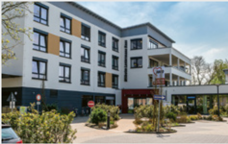
Wilhelm-Lantermann-Karree in Dinslaken wird fertiggestellt.
